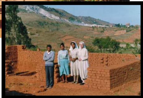
Una scuola in costruzione
