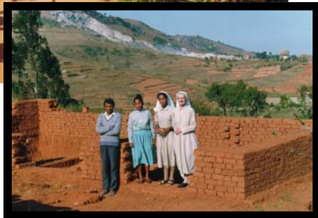
Una scuola in costruzione
